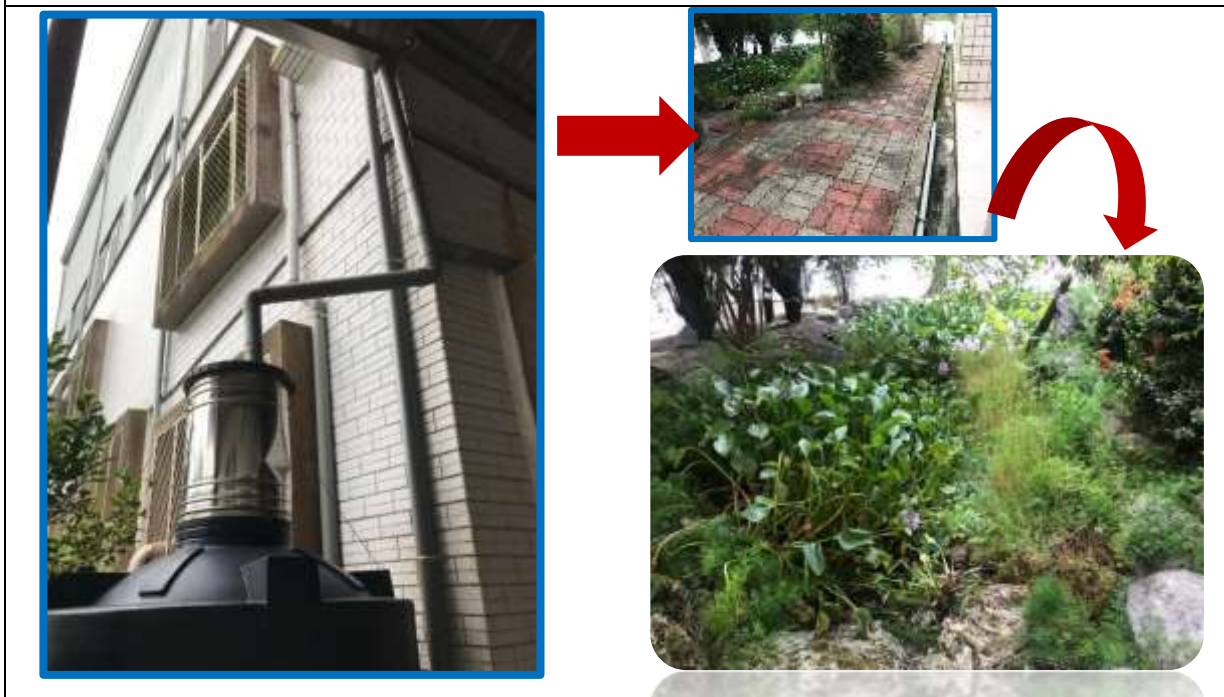
相片說明：生態池系統與飲水機及雨水回收管路連結
