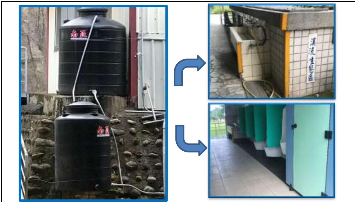
相片說明：善用溪水與自來水切換系統於洗手台及廁所沖洗
