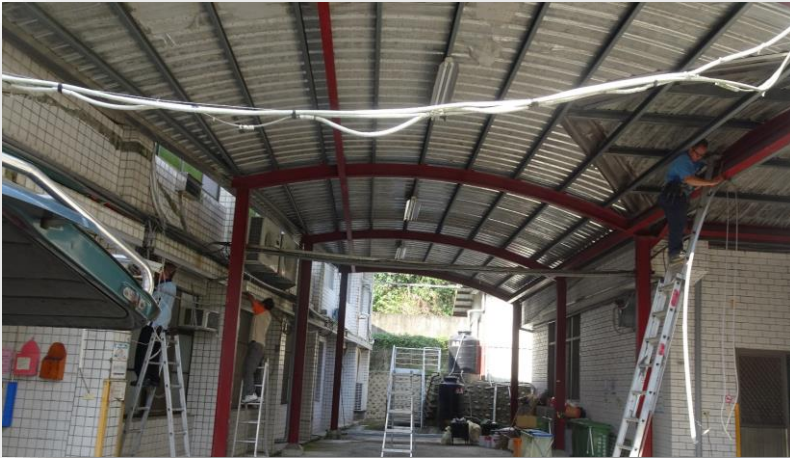
檢整學校老舊電線線路
